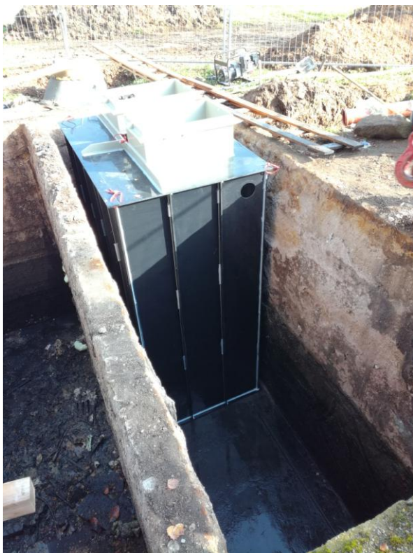
Původní stav septiku / úprava pro umístění šachet
