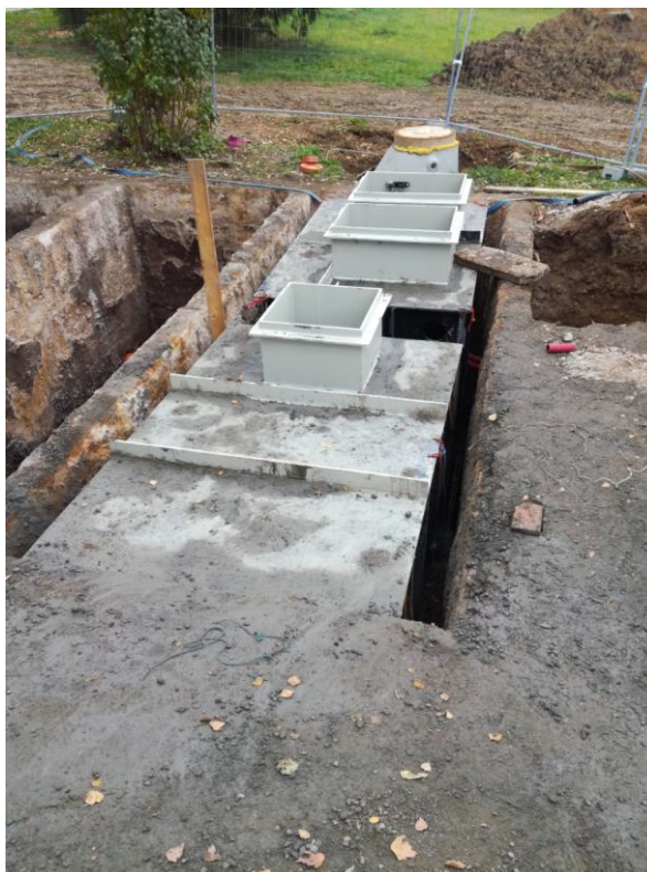
Nové nádrže – čerpací šachta/bezpečnostní šachta
