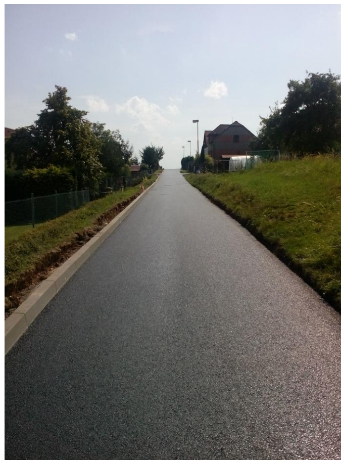
Nový stav místní komunikace
